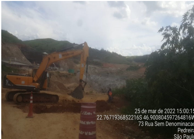
Foto 24: Implantação de Sistema de drenagem. (21/03/2022).
