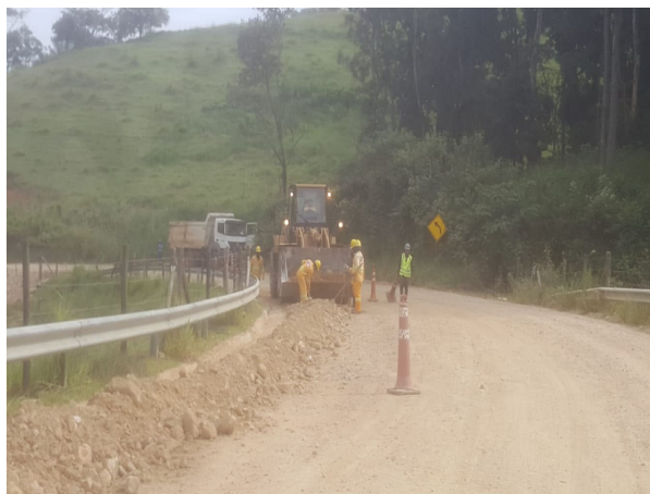
Foto 15: Manutenção no acesso MD03 (11/04/2022)
