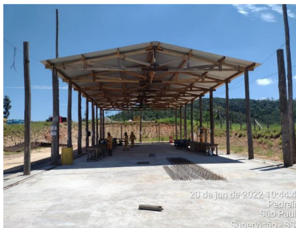
Foto 1: Situação atual das Estruturas no Canteiro operacional (20/01/2022)
