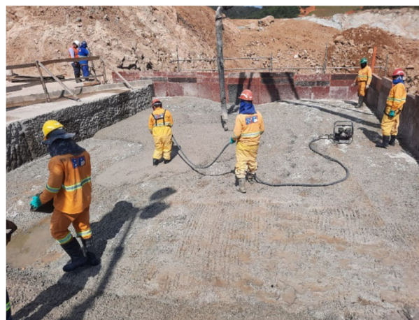
Foto 21: Aplicação de concreto (15/02/22).
