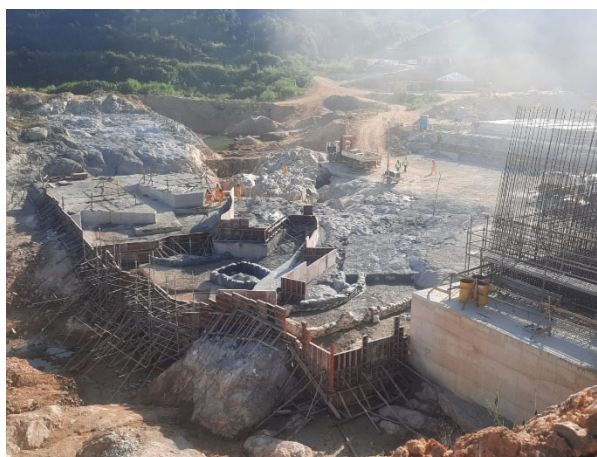
Foto 11: vista superior: tratamento de fundação (21/04/2022)
