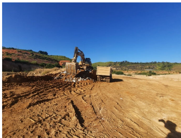
Foto 14: Escavação de material para rebaixamento (21/04/2022)
