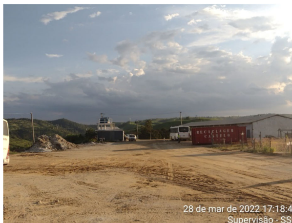
Foto 3: Situação atual das Estruturas no Canteiro operacional (28/03/2022)
