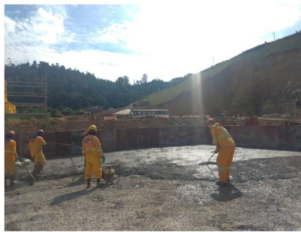
Foto 23: Concretagem no platô 589 (30/04/2022).
