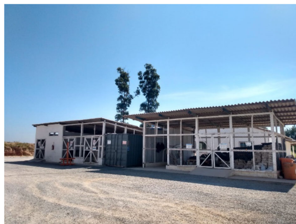
Foto 4: Situação atual das Estruturas no Canteiro operacional (22/04/2022)
