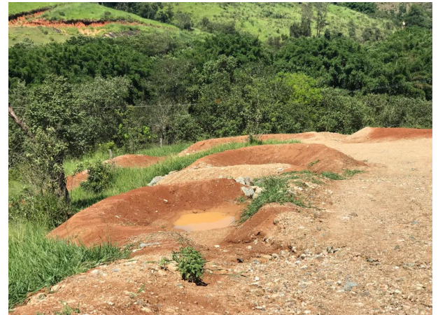
Foto 25: Plantio de placa de gramas no entorno da drenagem (24/03/2022).
