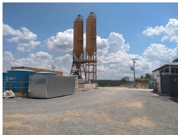
Foto 2: Situação atual das Estruturas no Canteiro operacional (28/02/2022)
