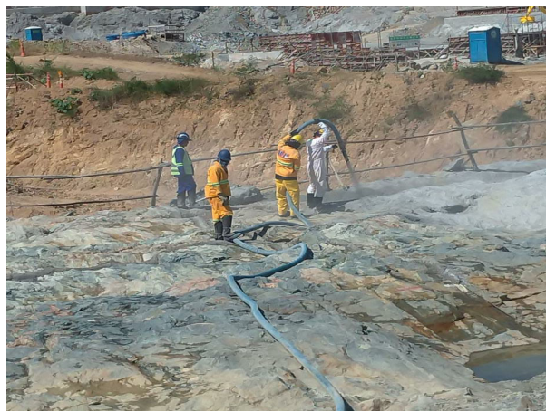
Foto 16: Aplicação de argamassa para regularização (21/04/2022)
