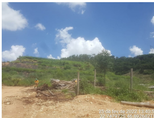
Foto 5: BF 3 Margem direita e pátio de madeira MD (25/02/2022)
